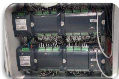
Instalação de 2 x **BFM-II** (versão sem display) em painéis, monitorando 30 cargas em processo industrial.
