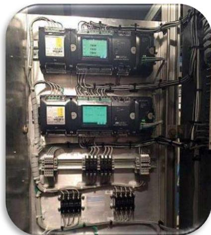
Instalação de 2 x **BFM-II** (versão com display) em painéis na indústria, monitorando 27 cargas.
